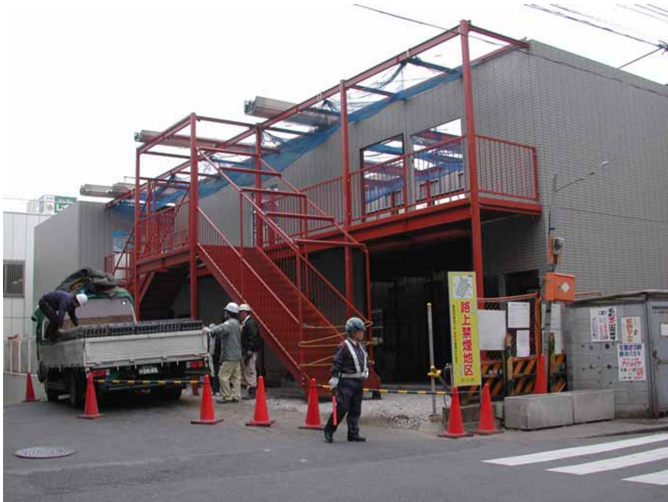
建設中の仮設店舗（旧再開発事務所の跡地）
