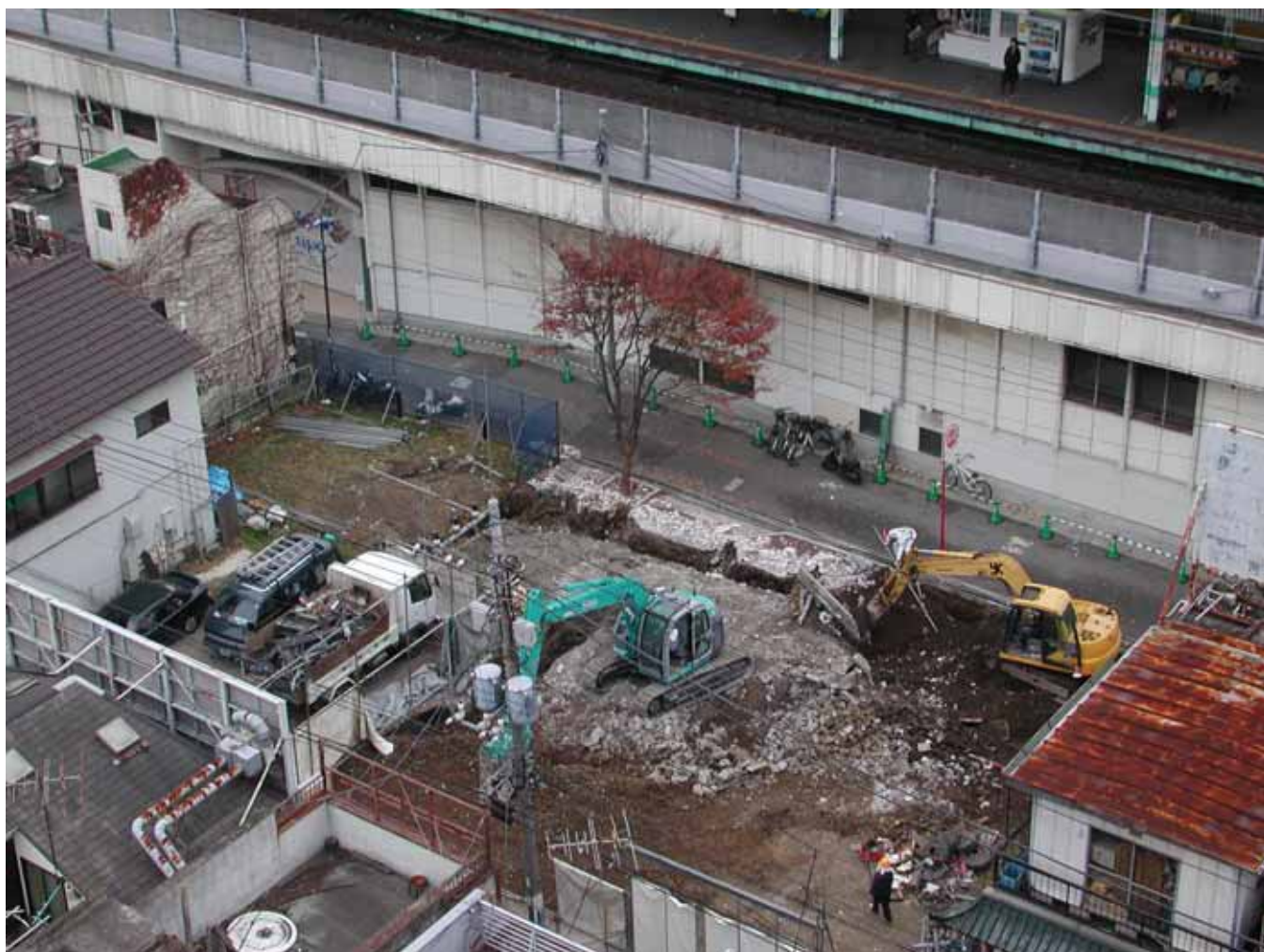
建物の取り壊し工事（B 街区）
