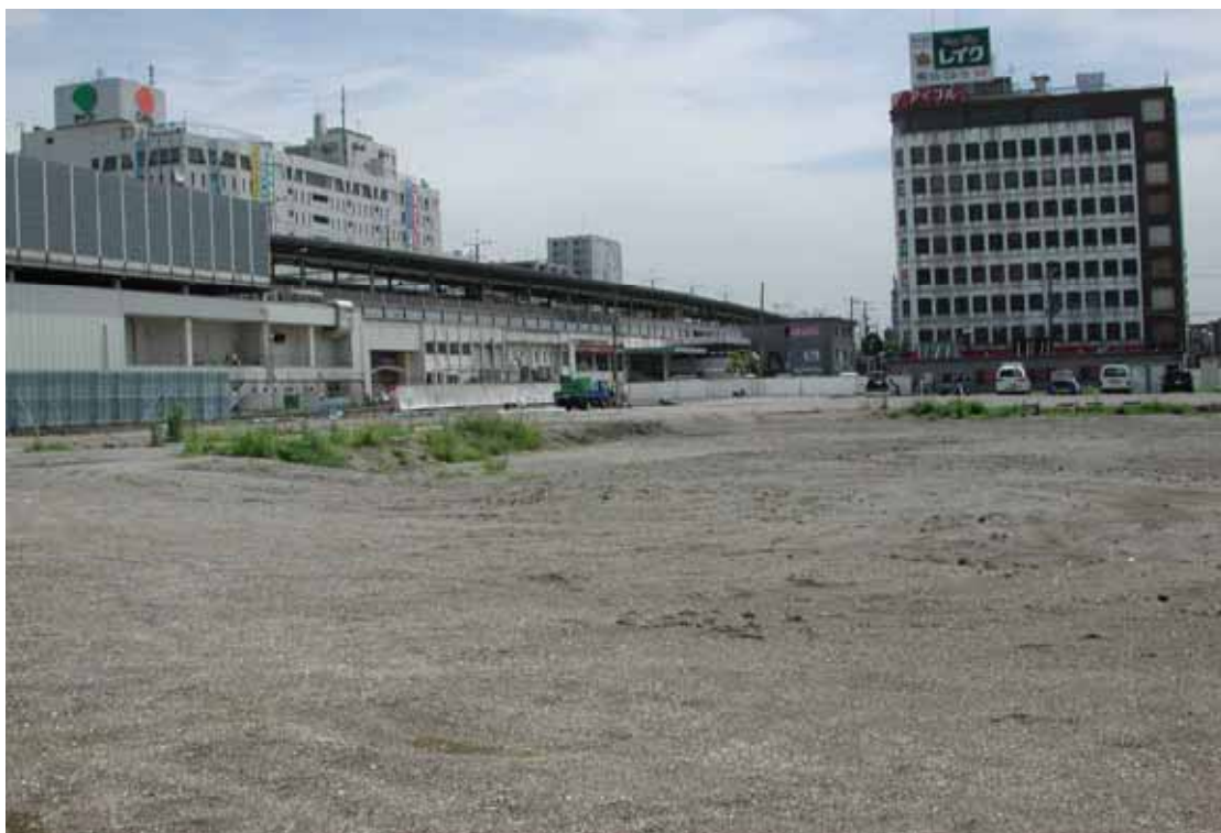
整地が進む再開発地区東京よりのA街区
