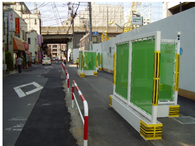
暫定防風フェンス
