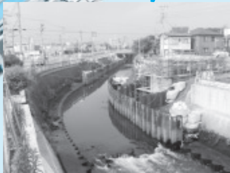
(仮称)大柏川渡河部橋 新設 大柏川を横断する橋の工事をしています。 〔平成21年6月の完成予定〕
