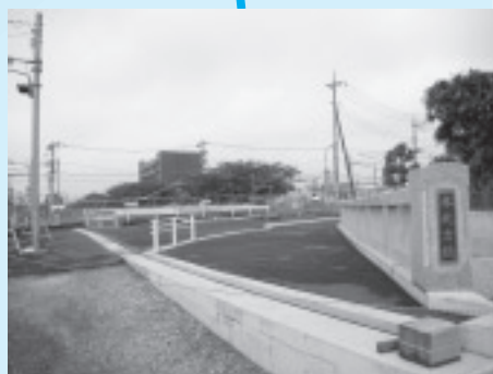
本北方橋 拡幅 〔完成〕
