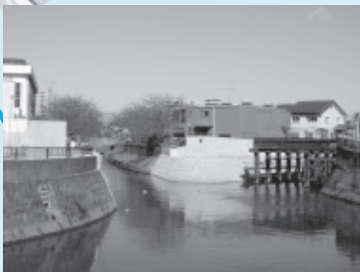
(仮称)B1・B2橋 新設 真間川と大柏川の合流部に架ける橋を整備して います。〔平成23年3月の完成予定〕
