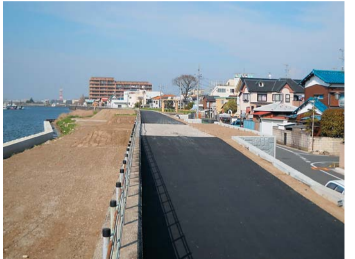
整備が進む常夜灯地区周辺
