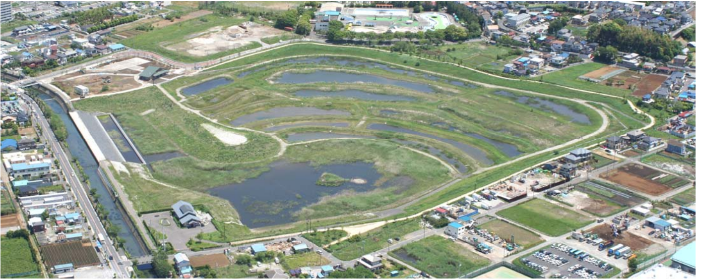
写真：大柏川第1調節池
