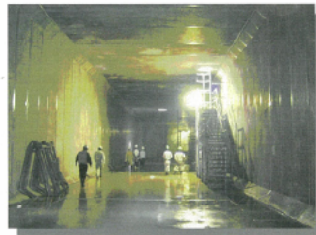
貯留槽内部は非常に広いです
