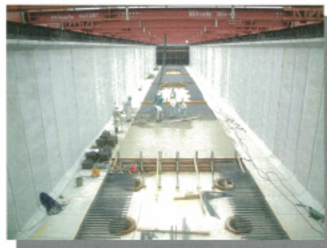
貯留槽の底部を作っています
