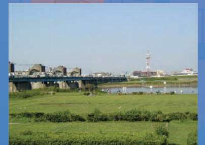
行徳橋と可動堰
