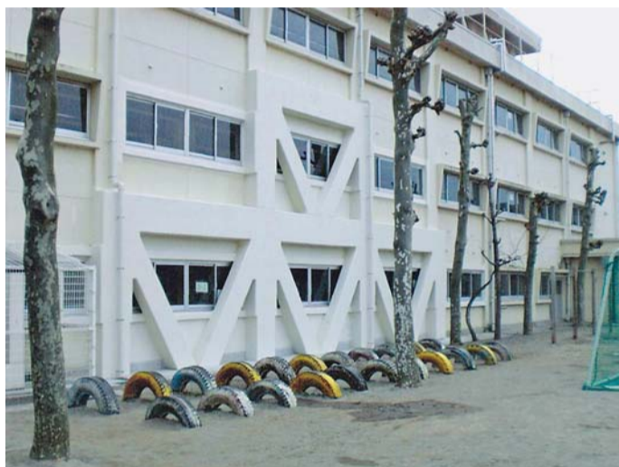
耐震改修工事が終了した小学校
