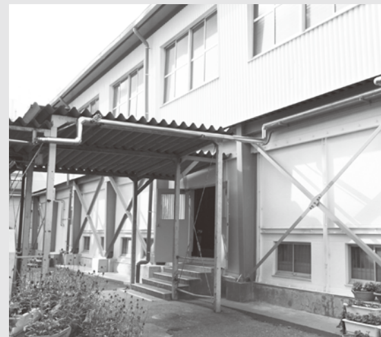
曾谷小学校体育館の耐震補強工事
