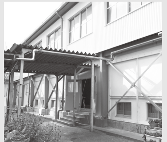
曾谷小学校体育館の耐震補強工事
