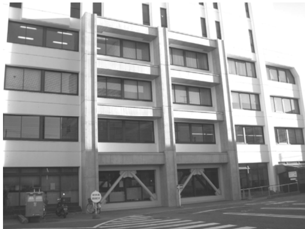
本庁舎の耐震補強工事
