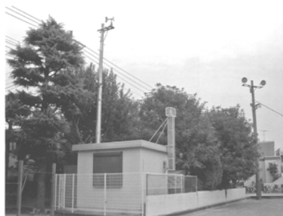
大気常時監視測定局舎
