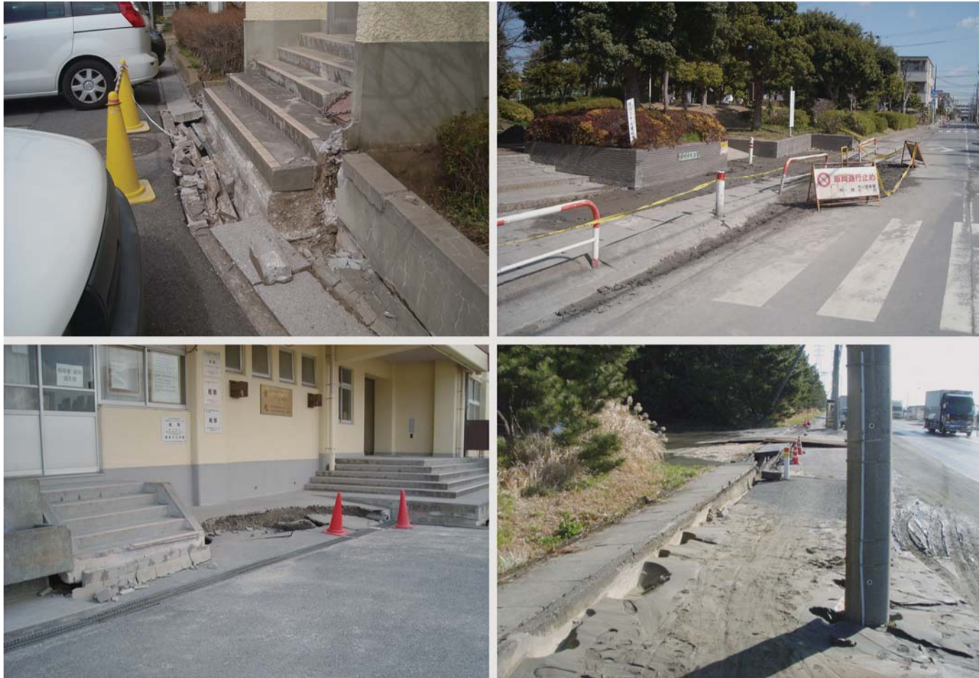
東日本大震災で液状化や地盤沈下などの被害を受け、補正予算で本格復旧工事が行われる施設 (左上) 塩浜小学校 (左下) 塩浜中学校 (右上) 塩焼中央公園 (右下) 塩浜1丁目地先の市道
