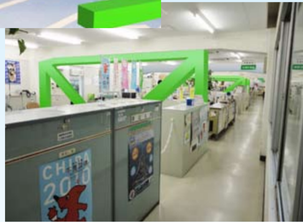
庁舎内部の補強イメージ
