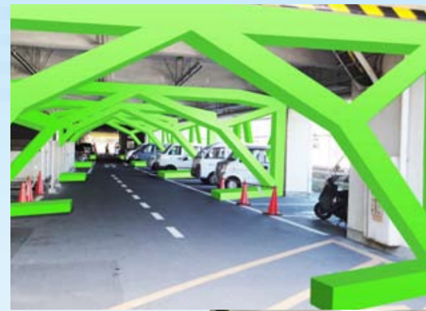
北側ピロティ部分の補強イメージ
