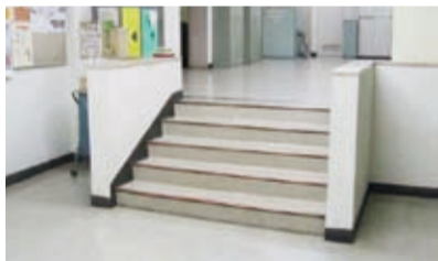
増築の際に生じた庁舎間の段差
