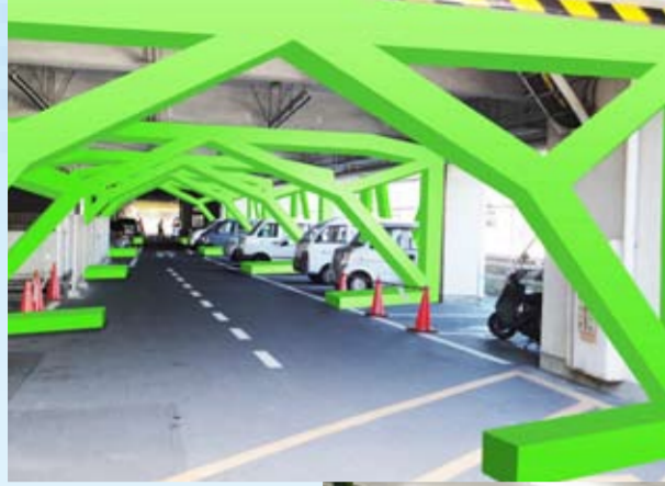
北側ピロティ部分の補強イメージ
