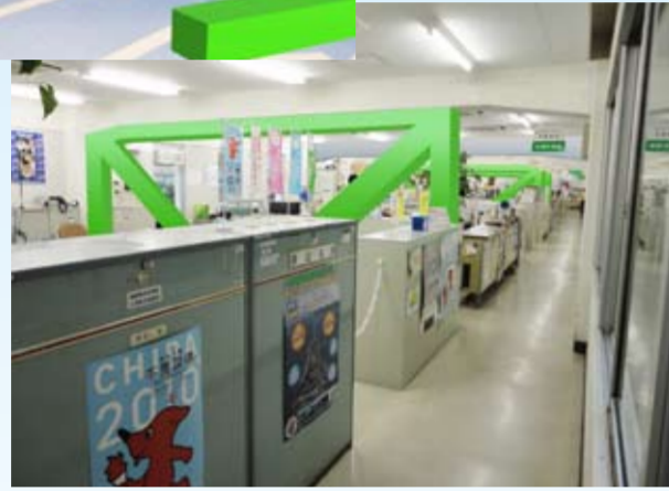
庁舎内部の補強イメージ
