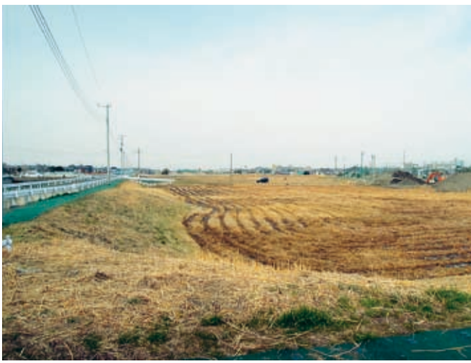
建設中の国分川調節池 (中池付近)
