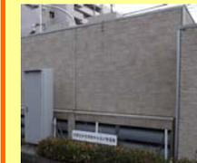
災害対策本部と通信設備へ電力を供給する非常用発電装置
