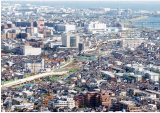
工事が進む東京外郭環状道路
