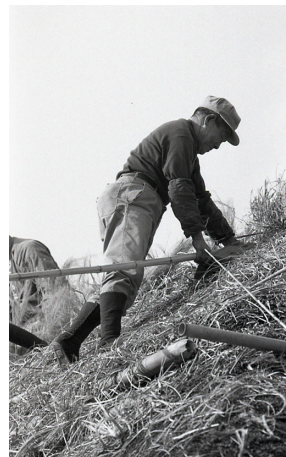
茅葺屋根の葺き 替え作業 昭和51年1月
