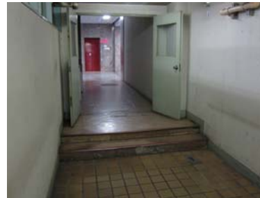
通路に生じた段差
