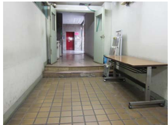
通路に生じた段差（第2庁舎内）
