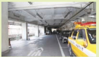
▲耐震工事が困難な第2庁舎
