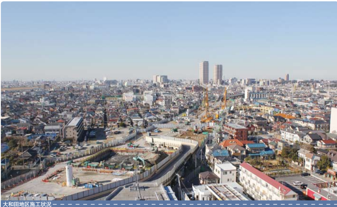
大和田地区施工状況
