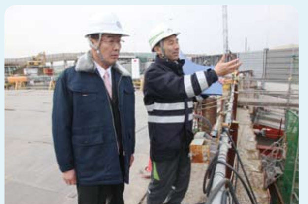
外環道路の工事現場で説明を受ける大久保市長
