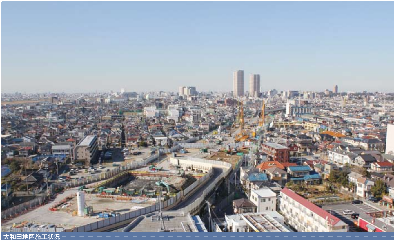
大和田地区施工状況
