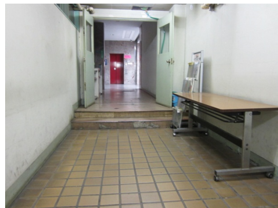
通路に生じた段差（第2庁舎内）
