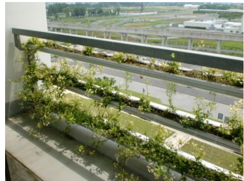
ベランダに設けられた緑のカーテン (つくば市役所／茨城県)
