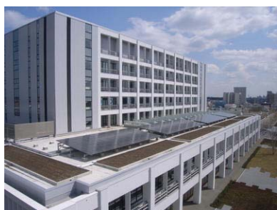
太陽光発電装置(他市事例より)
