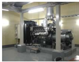
非常用発電装置
