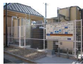
非常用給水設備
