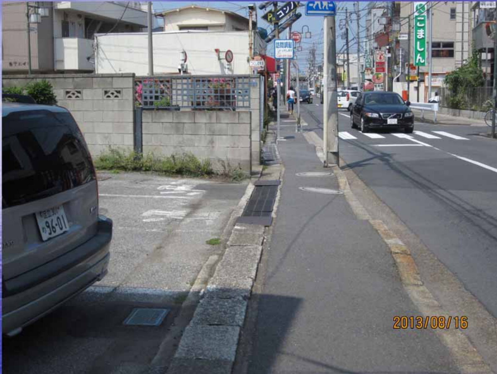
【歩道の現況】(つくし幼稚園へのアクセス路付近)
