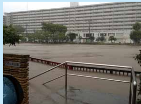
大野こごと公園 市街地の雨水を貯留。面積1.9ha、貯留量3.2万 m^3
