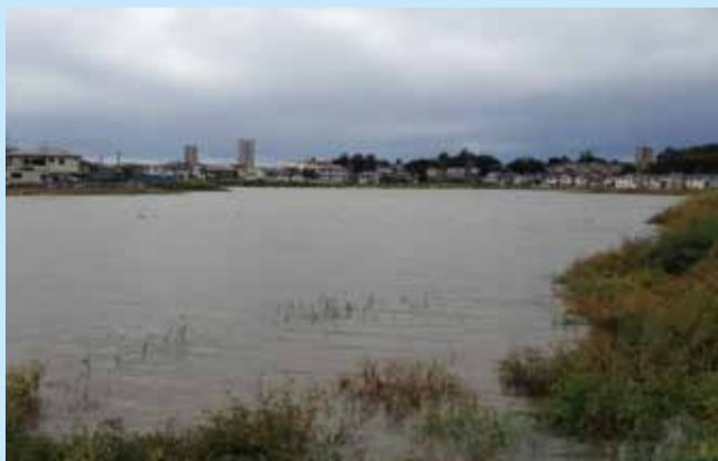
国分川調節池 国分川及び春木川の流量を調節。面積24ha、貯留量30.3万 m^3
