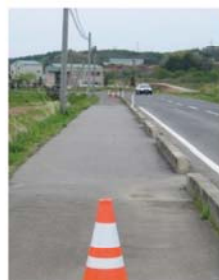
対策箇所（被害なし）
