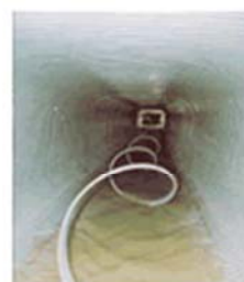
プラスチック材により既存管きよの内面を被覆
