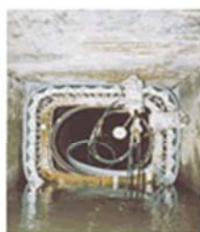
プラスチック材により既存管きよの内面を被覆
