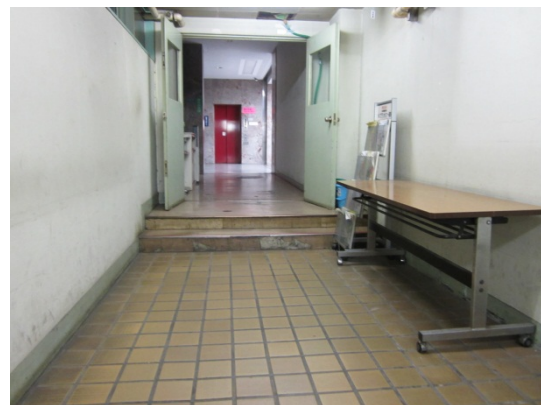
通路に生じた段差（第2庁舎内）
