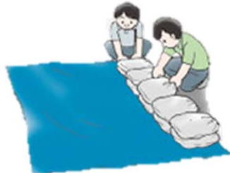
②ブルーシートの上に土のうを並べる
