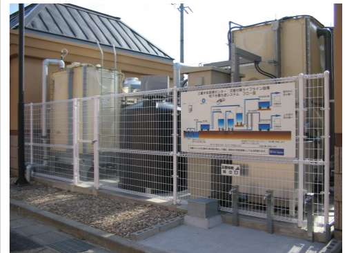
病院などで導入されている地下水ろ過システム
