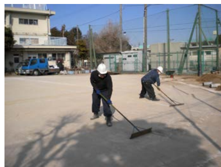
校庭表土の除去
