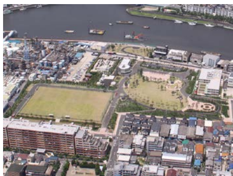
上空から見た広尾防災公園
