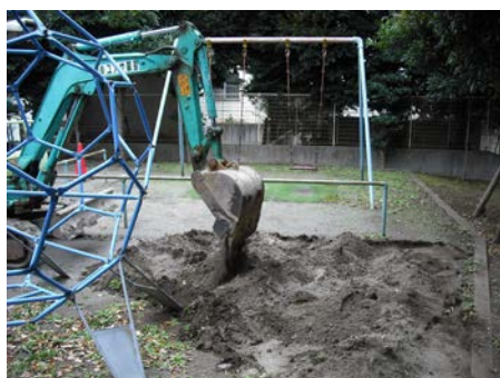
重機による土の掘り起こし
