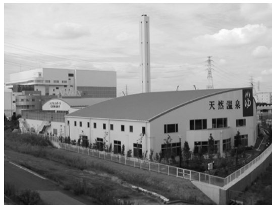
クリーンスパ市川全景（奥に市川市クリーンセンター）
