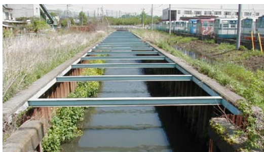
整備前：鋼矢板護岸
