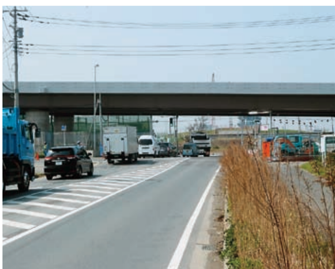
都市計画道路3・4・13号(下)と外環道路(高谷3丁目)
