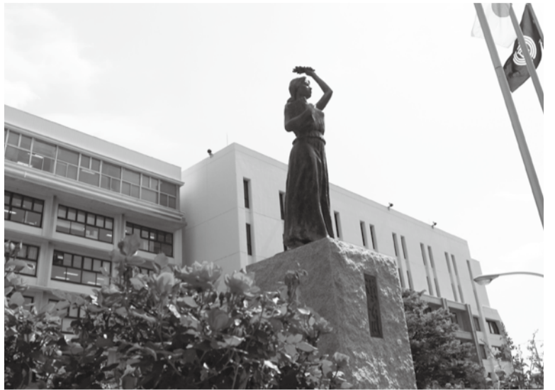
▲主な市民向けサービス窓口がある本庁舎
