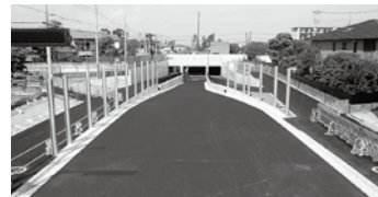
▲工事が進む都市計画道路3・4・18号
