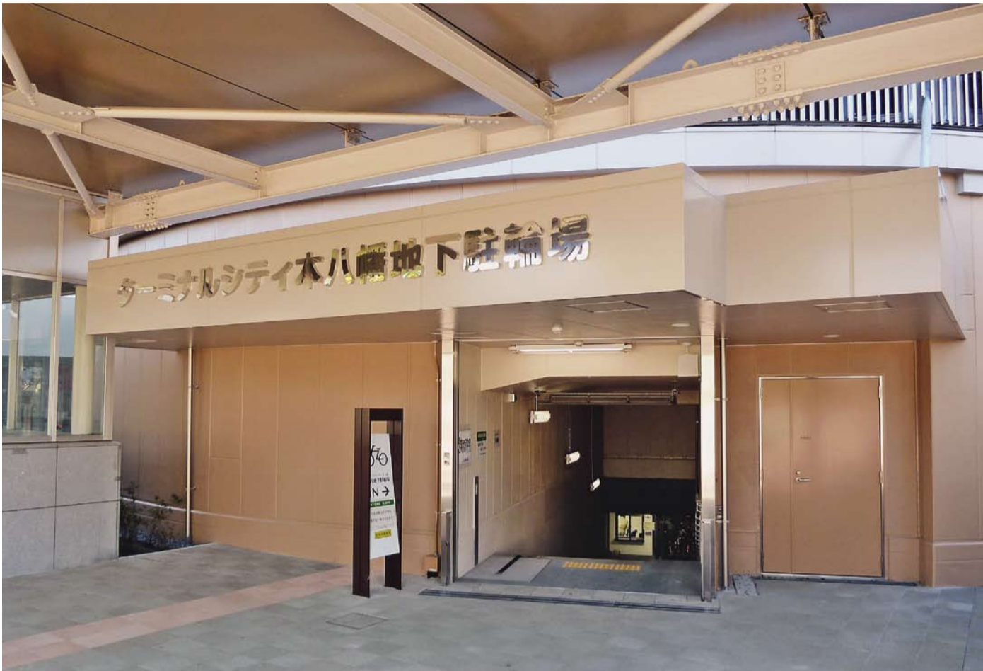
平成27年10月にオープンした市営ターミナルシティ本八幡地下駐輪場
