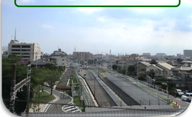
京成本線北側から国道14号方面
