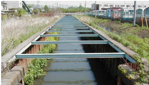
整備前：鋼矢板護岸
