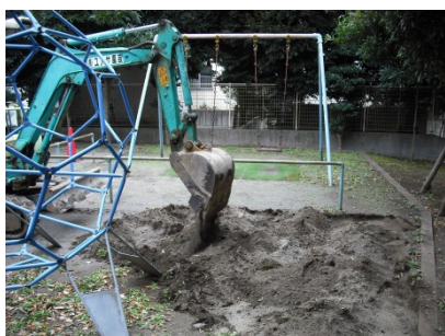
重機による土の掘り起こし
