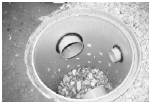
雨水浸透施設（浸透樹）
