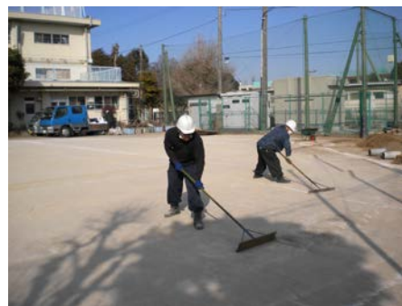
校庭表土の除去
