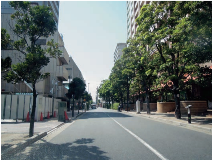
無電柱化された道路(市川南1丁目)
