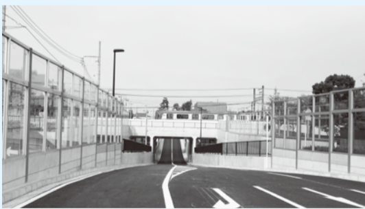
▲平成28年11月に全線開通した都市計画道路3・4・18号 排水路上部のふたかけ歩道の改修 4,918万円
