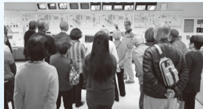
▲クリーンセンターの中央制御室
