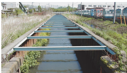
整備前：鋼矢板護岸
