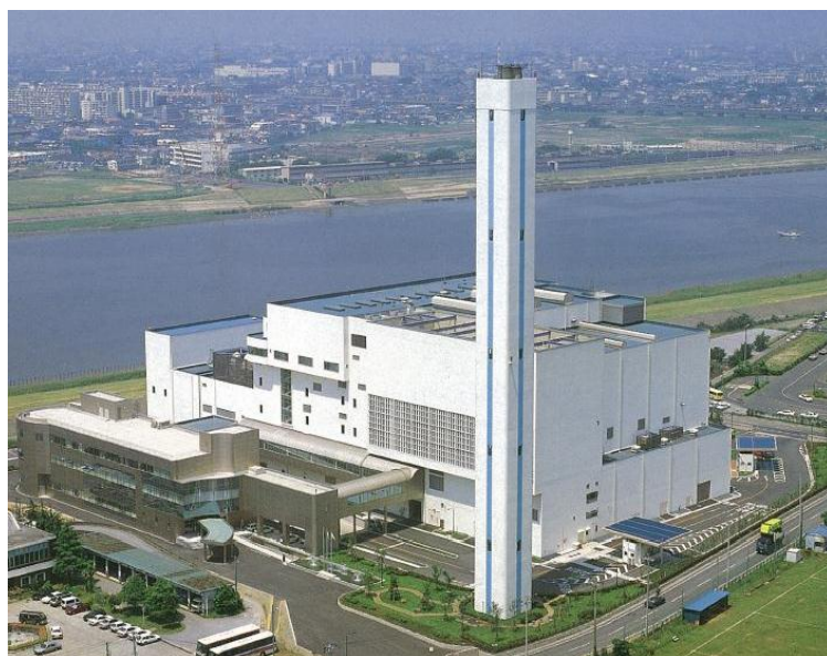
市川市クリーンセンター
