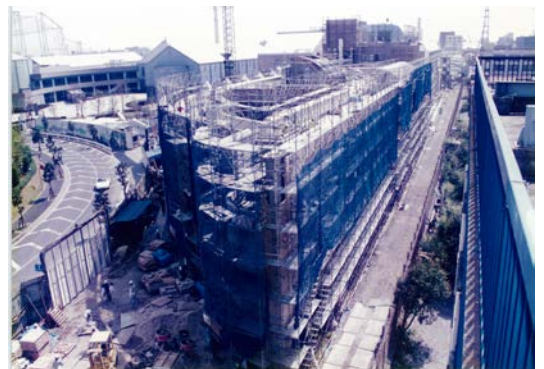
建設中の中央図書館
