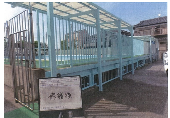
施工後（平成29年6月30日完了）
