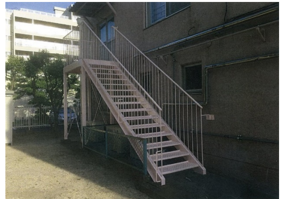
施工後（平成29年5月31日完了）
