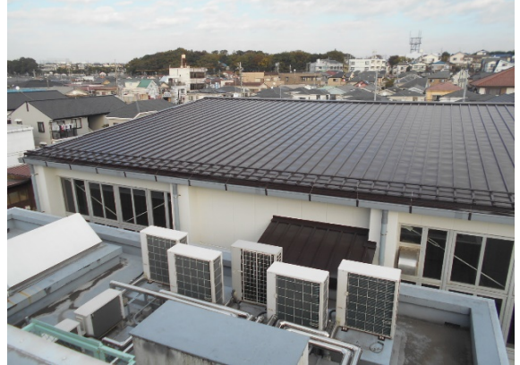
施工後（平成29年11月10日完了）
